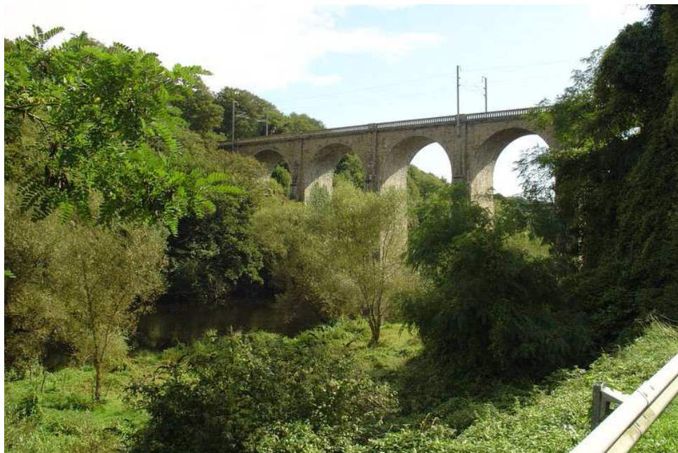
PONT FERROVIAIRE CROSSING / ENJAMBANT UNE RIVIÈRE ET SA VALLÉE.
